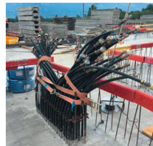
Im bisher grössten Projekt der Enercret AG in der Schweiz wurden auf dem Mattenhof Areal in Kriens 1200 Energiepfähle ausgebildet.
